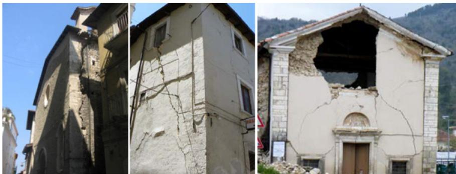
Fig. 1 – Meccanismi di ribaltamento di pareti murarie (L'Aquila 2009): a) ribaltamento isolato della facciata; b) ribaltamento con formazione del cuneo ortogonale; c) ribaltamento della porzione centrale
