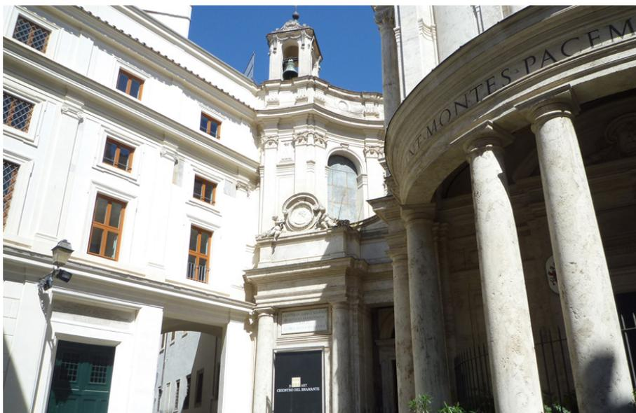
12 Prospetto sud, tinteggiatura finale a bicromia su scala del "colore del travertino", si notano sul secondo ordine le tassellature di descialbo con l'originario "colore dell'aria" delle specchiature lasciate a vista per un successivo intervento che, per la riproposizione, dovrà necessariamente investire tutta la scenografia progettata da Pietro da Cortona.
