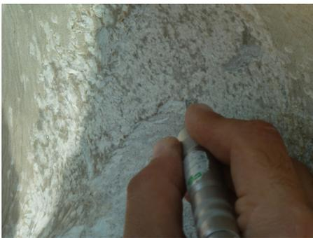
14 Microscalpello elettrico utilizzato nella rimozione dei depositi calcari.
