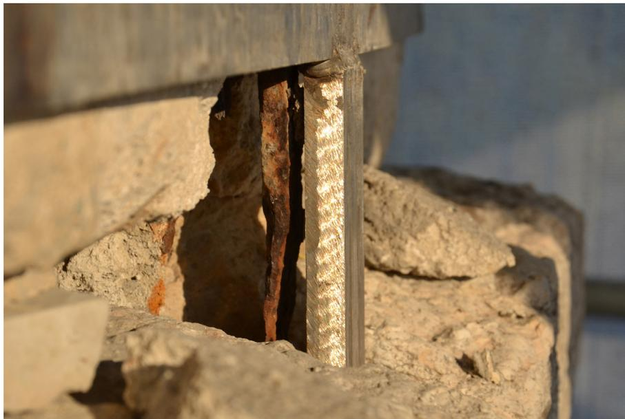
4 Podio della statua. La cerchiatura metallica esterna in acciaio inossidabile è stata saldata agli elementi metallici decoesi, accelerando il fenomeno di ossidazione.
