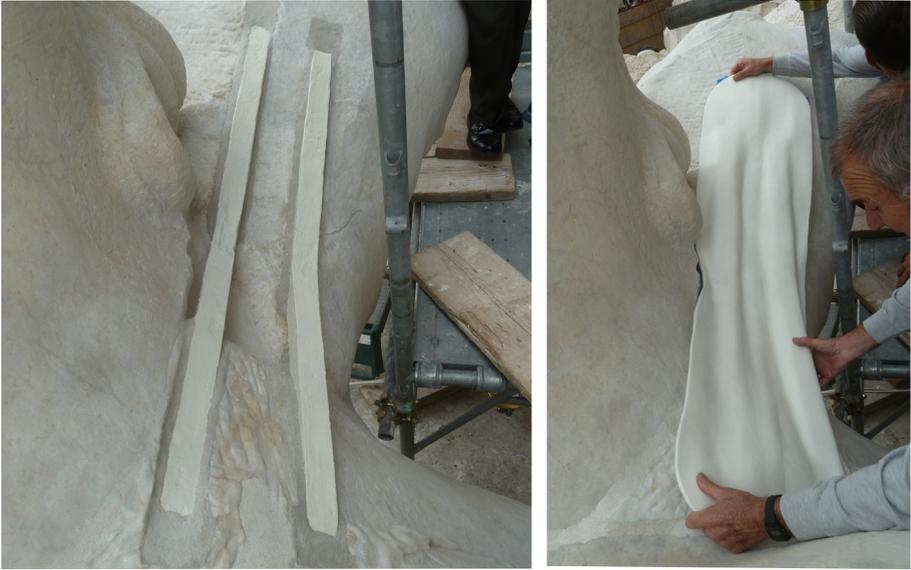
24 Restauro delle staffe metalliche: rimozione ruggine, protezione con resine e verniciatura. 25 Scudo in vetroresina a protezione dell'insolazione diretta.
