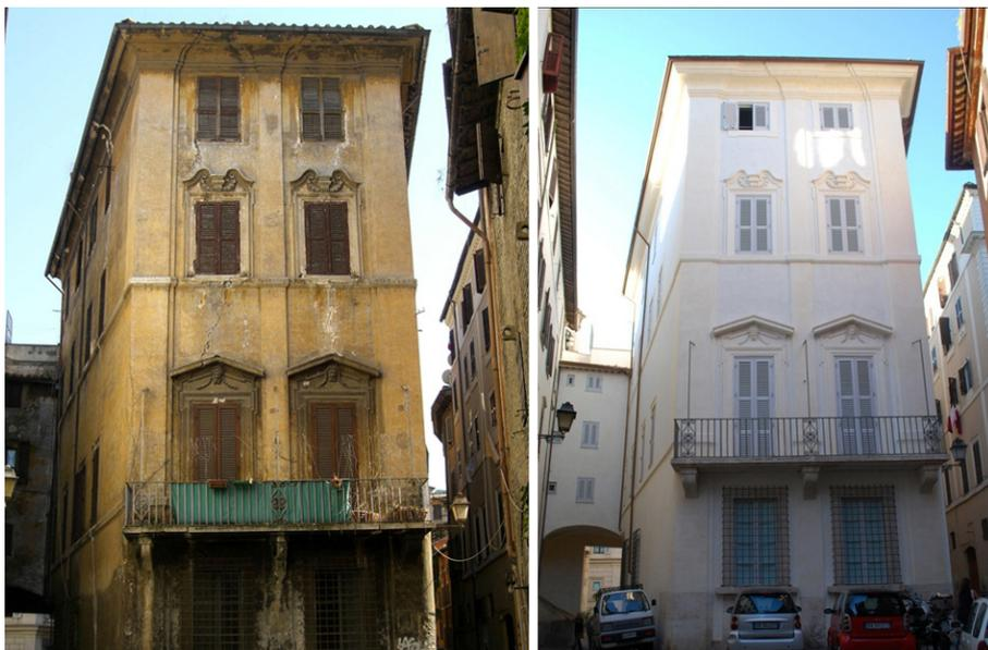
11 La testata nord su via dell'Arco della Pace prima e dopo l'intervento di restauro con la bicromia "colore dell'aria" e "color del travertino".
