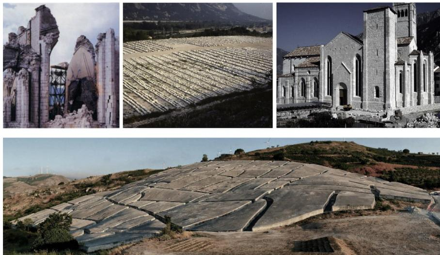
2a Venzone: la ricostruzione del Duomo: situazione post-sisma, catalogazione delle macerie, stato post intervento.
