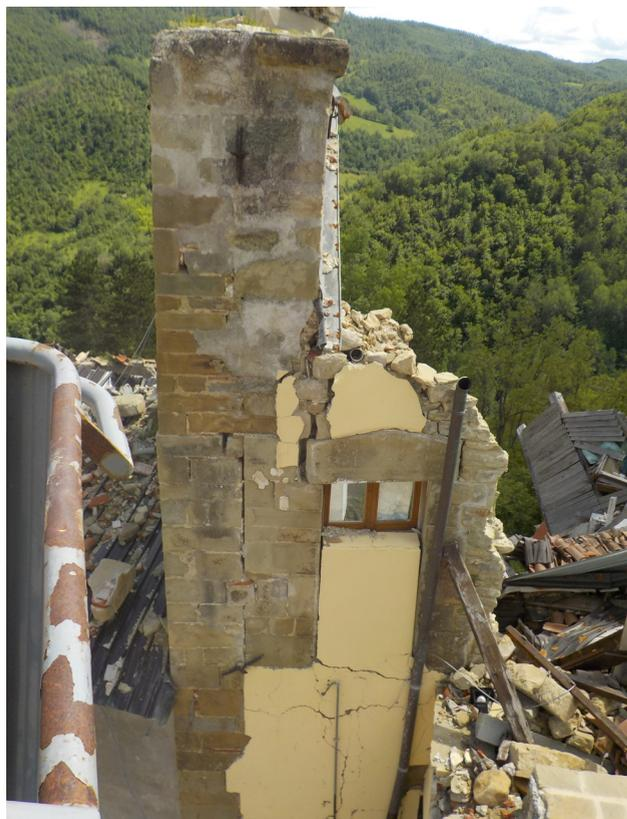
4a Una vista della torre campanaria prima dello smontaggio controllato di alcuni filari.
