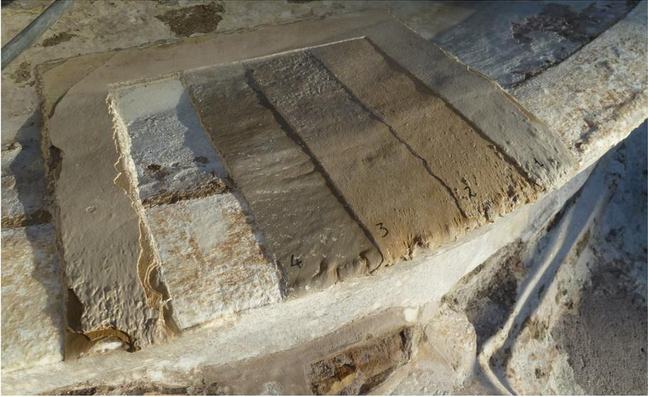
16 Rimozione dei depositi di calcare dai bordi delle vasche.
