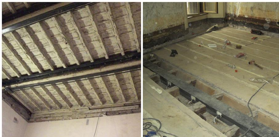
3 Immagini delle due tipologie di rinforzo delle travi in legno.
