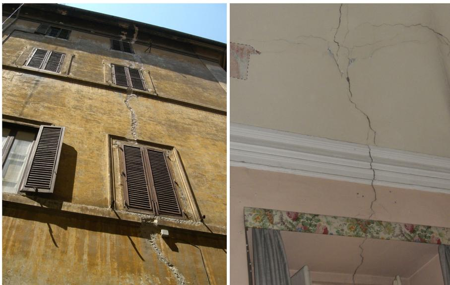
1 Le lesioni interessavano in modo esteso le strutture. Si noti la ramificazione delle lesioni sulle volte
