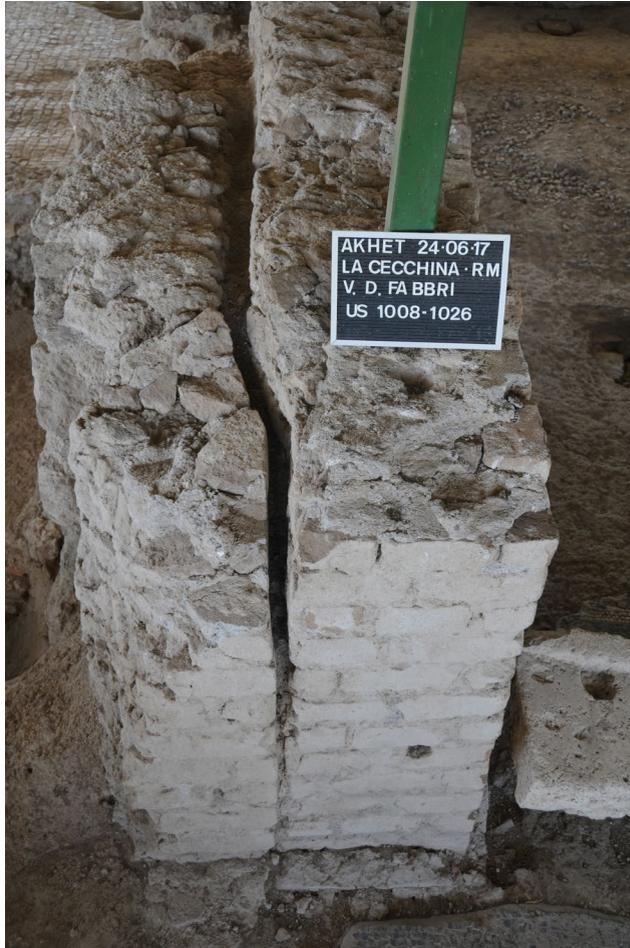
12 La Cecchina (Roma). Terme di via Diego Fabbri. Particolare della testata aggiunta al muro in spezzoni di tufo della fase 2 (a sinistra) e conseguente adattamento del successivo muro in reticolato (a destra).
