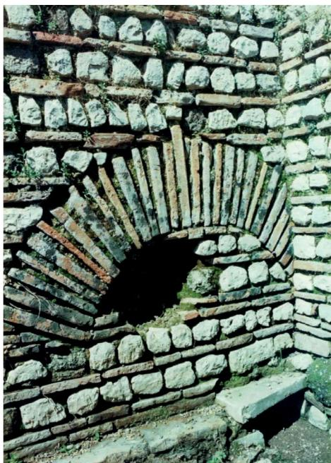
18 *Privernum* (Priverno, LT). Edificio termale. Latrina (8), arco di scarico sovradimensionato rispetto all'ampiezza del condotto fognario sottostante. In evidenza l'accurato trattamento dell'imposta in rapporto allo spigolo del muro e le dimensioni del giunto in chiave.
