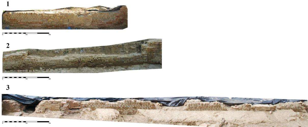
3 Santa Marta (Cinigiano, GR). Campionatura di tecniche costruttive murarie: 1. Paramento interno del lato nord dell'Ambiente 3, Edificio A (*opus mixtum* e tamponatura tardoantica); 2. Paramento interno del lato nord dell'Ambiente 1, Edificio A (opera testacea); 3. Paramento esterno del perimetrale orientale dell'Edificio B (*opus mixtum* con reticolato policromo), con la rampa in ciocciopesto e le aperture aggiunte nella Fase III, tardo III-IV secolo d.C.
