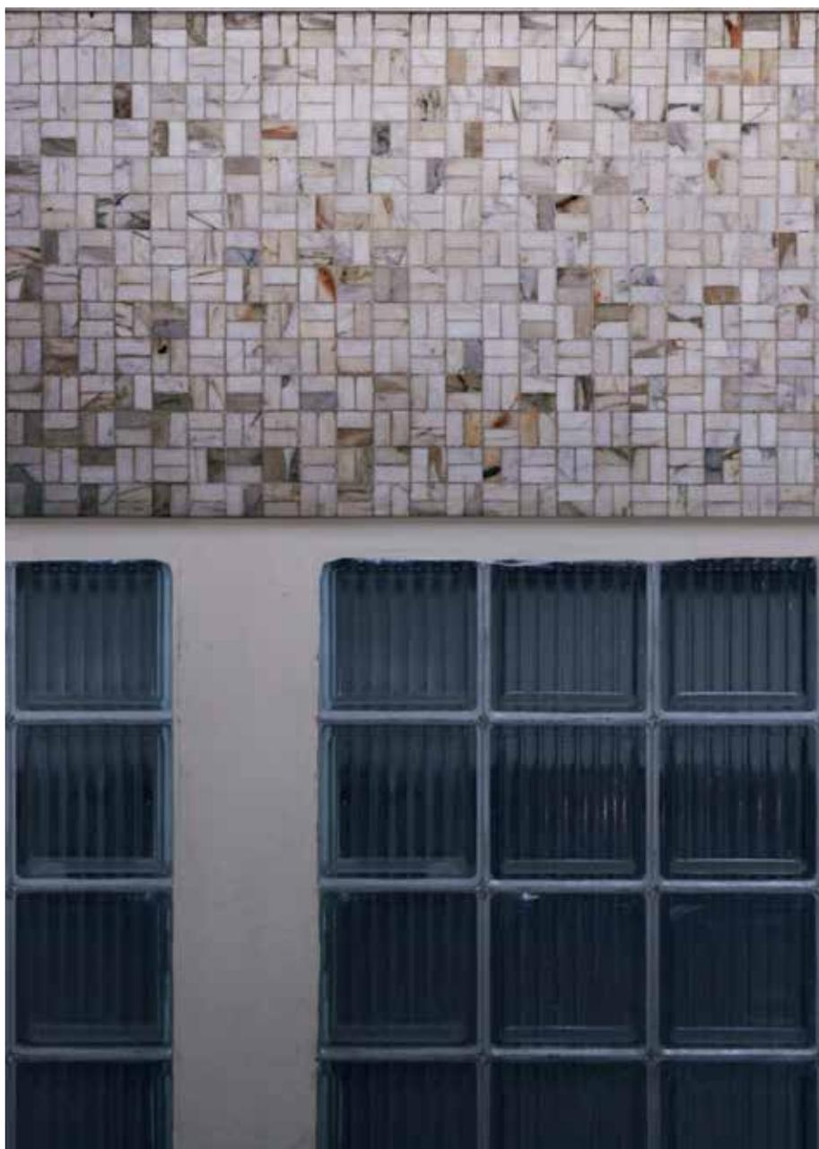
Rivestimento e tamponamento interni vano scala di servizio; marmi e vetrocemento.
