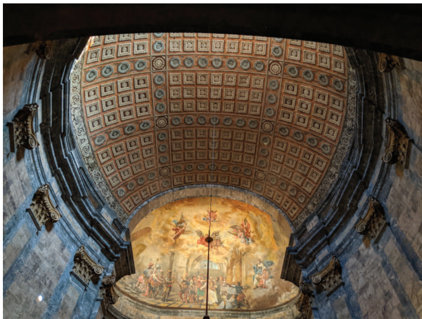
Figura 8. Fragmento de la bóveda donde se aprecia el perfil elíptico de la planta en la capilla de San Narciso. Colegiata de San Félix (Girona). Fotografía: Manel Trenchs.
