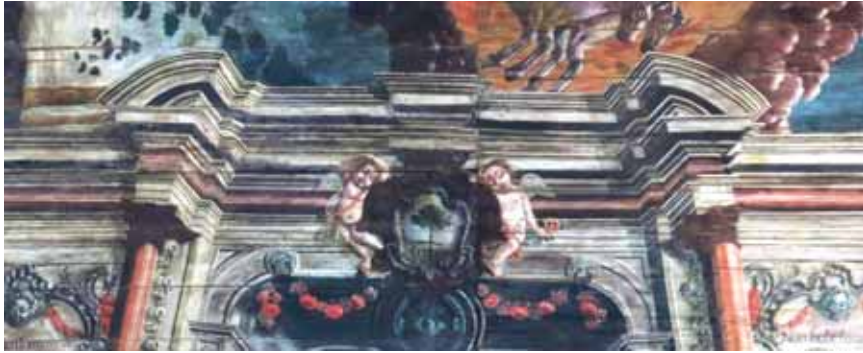
Figura 28: Forro da nave central do Carmo de Diamantina. Detalhe. Fonte: Foto de Mateus Rosada.
