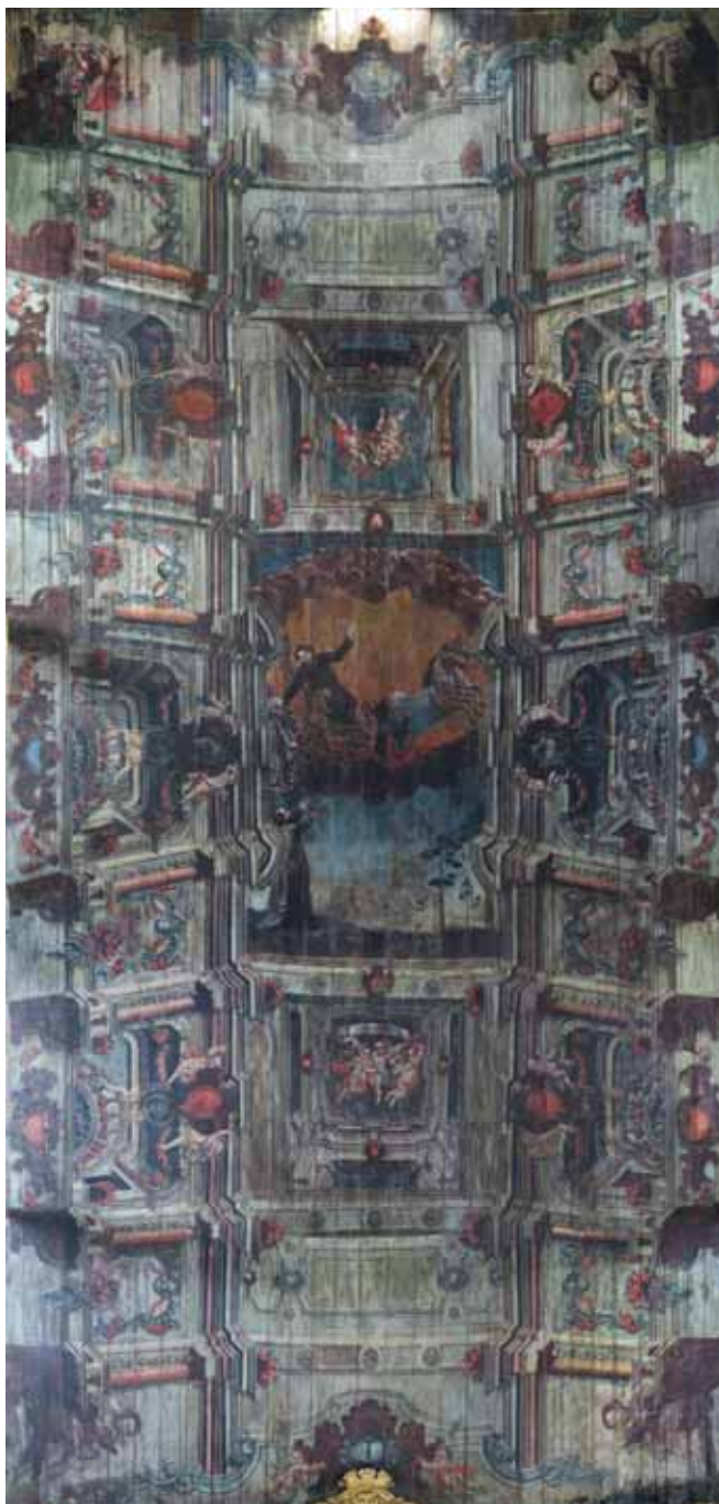
Figura nº 16: Teto da nave Central da Igreja do Carmo. Fonte: Foto de Mateus Rosada
