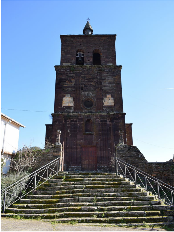
Figura 2. Fachada de la iglesia de San Miguel de Montefurado, ca. 1756-1767. (Fotografía del autor. Propiedad: Diócesis de Lugo).
