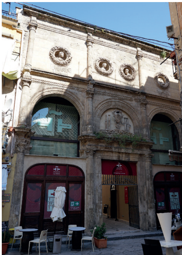
fig. 8. Palermo, facciata della loggia nuova dei Catalani, 1538 ca. (fotografia Emanuela Garofalo).
