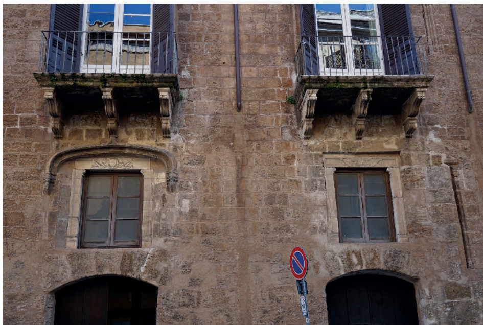
fig. 1. Palermo, palazzo Aiatamicristo, particolare di due monofore del primo livello (fotografia Emanuela Garofalo).
