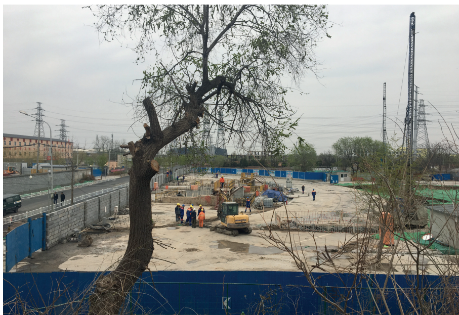
Figura 2. Dopo la demolizione - anno 2019
