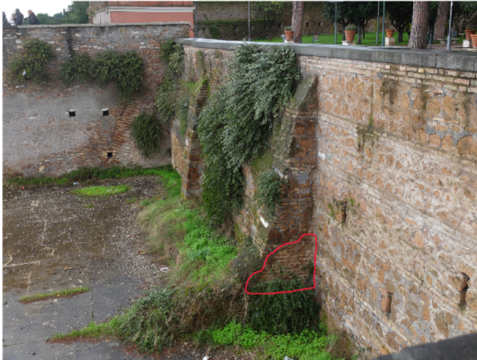
Fig. 7. Cinta del Giardino degli Aranci, lato N, prospetto esterno: il contrafforte con alcuni corsi di blocchetti di tufo duecenteschi, e sua localizzazione in pianta (foto, pianta e grafica di E. Santella).
