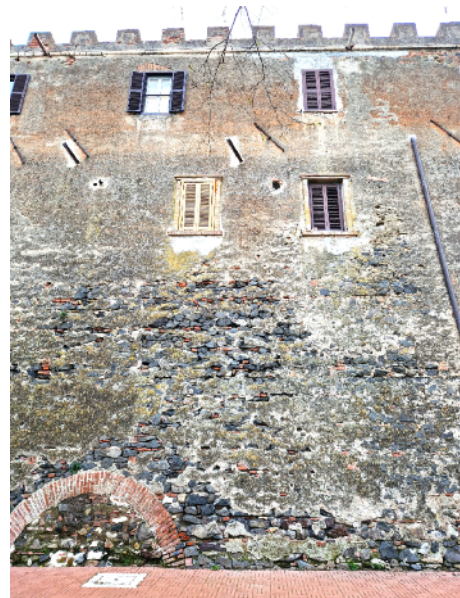
Fig. 7. La stratificazione delle mura di Montalto di Castro (VT) (foto M. Bernardi).
