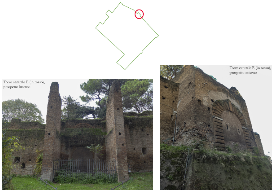
Fig. 5. Cinta del Giardino degli Aranci, torre E: prospetto interno ed esterno, e sua localizzazione in pianta (foto, pianta e grafica di E. Santella).
