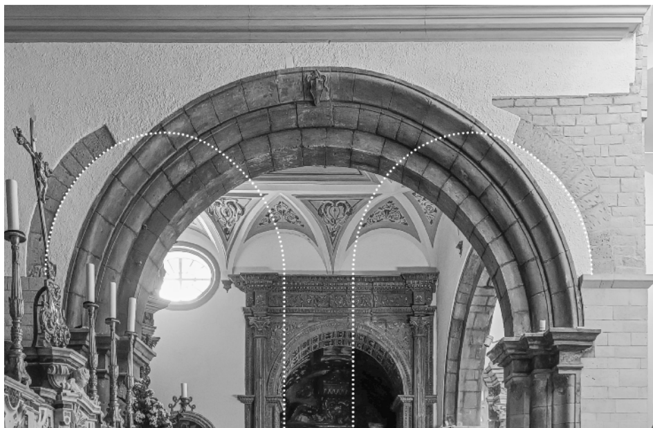
Fig. 1. Melfi, coro della cattedrale, ricostruzione del doppio fornice del deambulatorio normanno (rielab. Autore; foto L. Mercuri, Roma).
