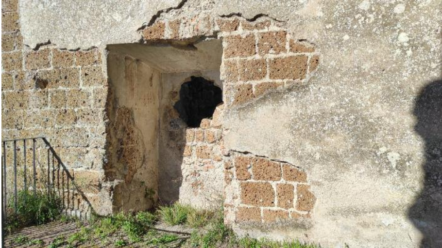
Fig. 5 – Traccia della «credenza da muro» presente nell'ambiente C del primo piano del Palazzo Altieri di Monterano.
