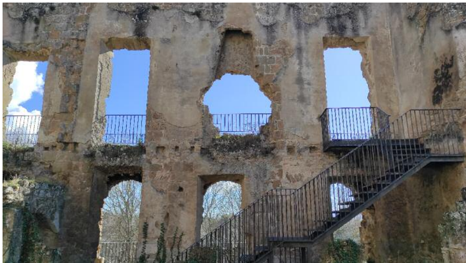
Fig. 6. – Traccia del grande camino della Sala del primo piano del Palazzo Altieri di Monterano.
