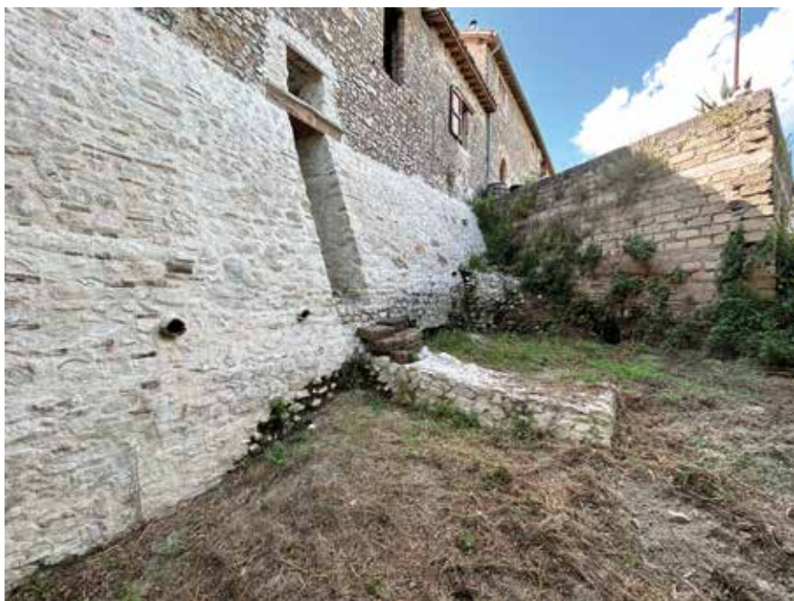
Fig. 8. Casperia, Paranzano: strutture murarie in opera incerta affioranti alla base dei casali moderni che le usano come fondazioni.
