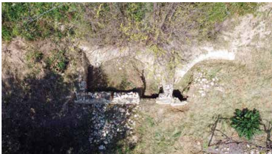
Fig. 9. Casperia, Paranzano: sostruzione contenitiva di terrazzamento a nicchioni.
