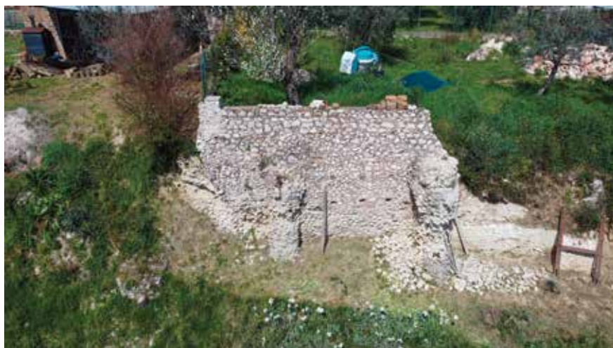
Fig. 10. Casperia, Paranzano: sostruzione a concamerazioni coperte da volta a botte.
