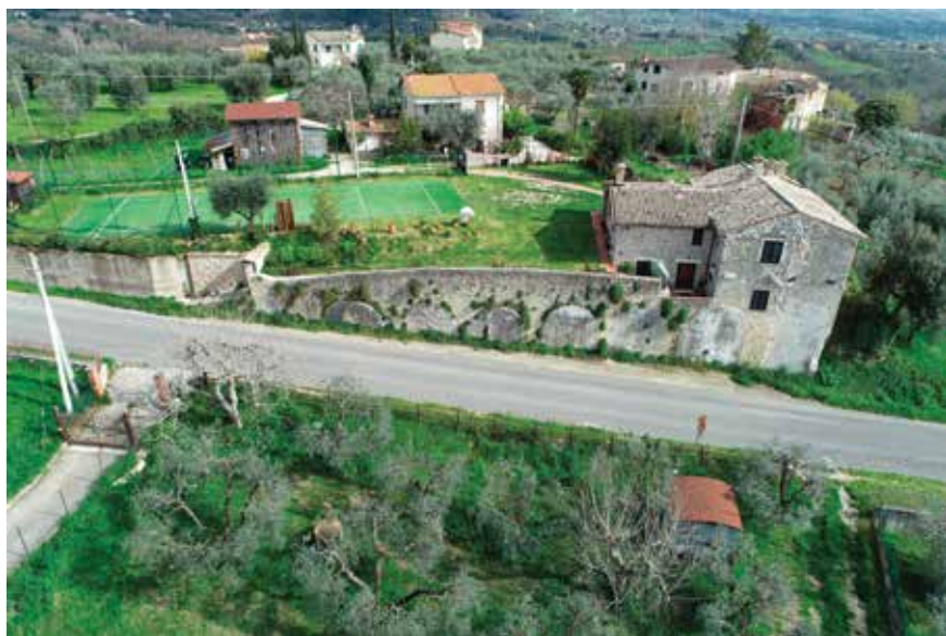
Fig. 11. Casperia, Paranzano: lato occidentale del grande terrazzamento con contraforti ad arco o concamerazioni.
