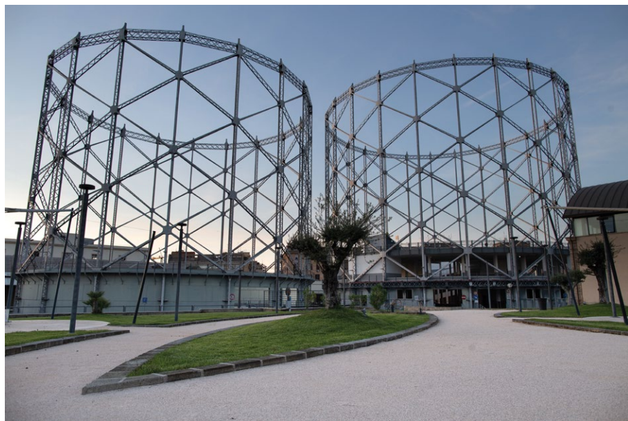
Fig. 2. Vista sulle aree riqualificate. Fonte: Archivio ROAD
